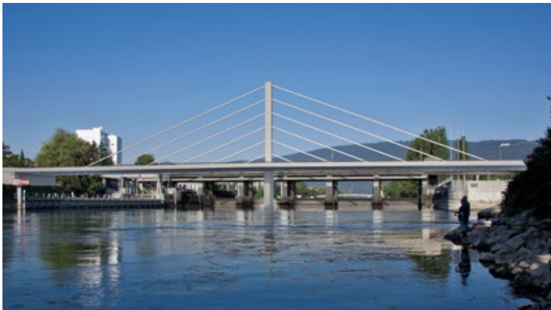
Städtebaulich nimmt die Schrägseilbrücke Bezug auf das Hochhaus (links) und den Hochkamin der KVA.
