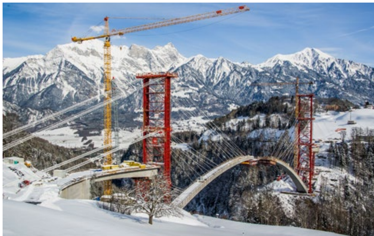
Musterbeispiel eines Freivorbauverfahrens : Bis zum Bogenschluss trug das Hilfsgerüst die auskragenden Bogenhälften.
