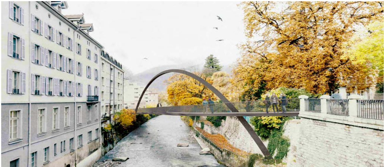
Gerahmter Fluss: Das Siegerprojekt «Arcocoira» von Bänziger Partner und Ritter Schumacher überspannt den Wasserlauf mit einem Bogen, unter dem sich die leicht mäandrierende Fahrbahn hindurchschlängelt.
