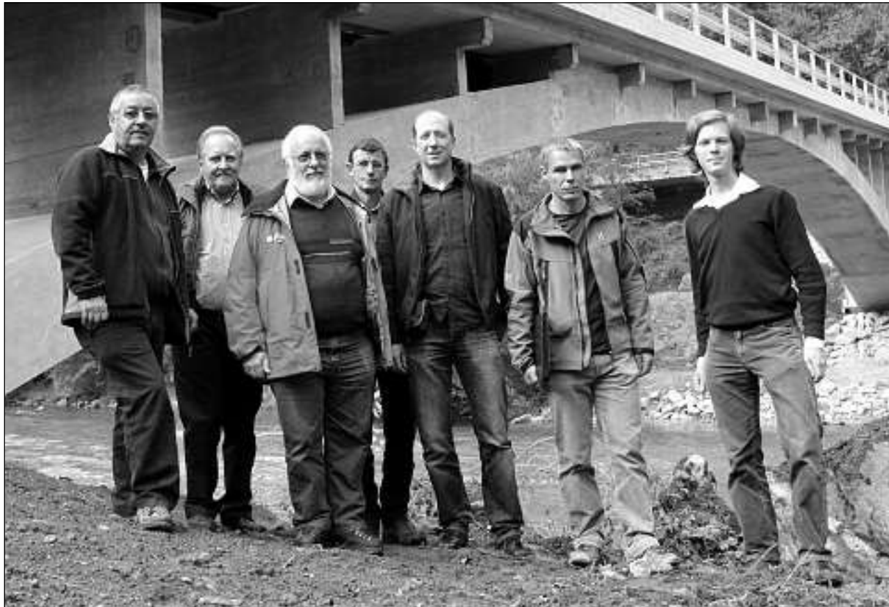
La sanaziun dalla punt sur il Rein a Vuorz ei terminada. Ils representants dalla vischnaunca, digl Uffeci d'uaul dil Grischun, dils biros d'inschignier e dall'interpresa da baghegiar ein satisfatgs dall'ovra.
