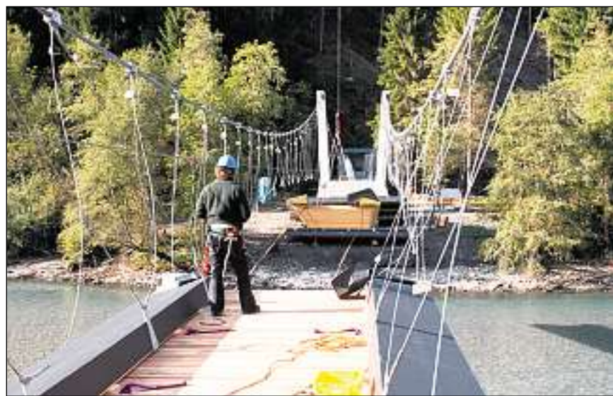
La punt pendent sur il Rein a Trin staziun ei accessibla naven dalla primavera proxima.
