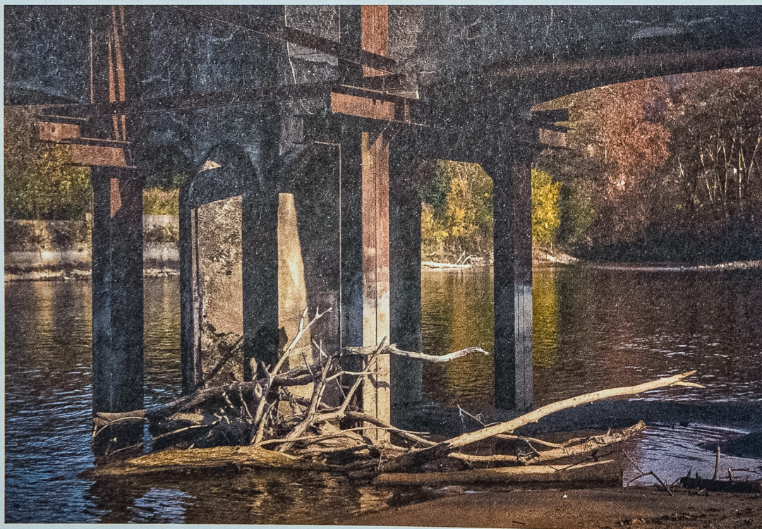
Seit 2019 verstärkt eine Stahlkonstruktion einen der beiden Pfeiler.
